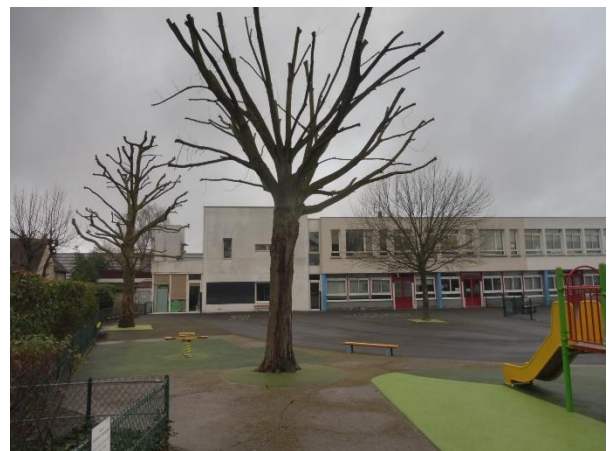
Photo n°8 : Revêtement imperméable au pied des arbres – Ecole des Cerisiers
